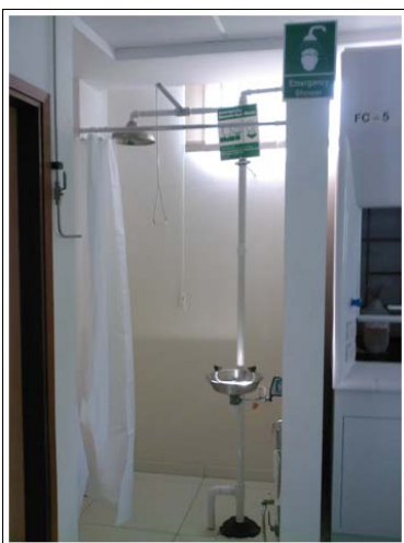
การจัดแยกพื้นที่ภายในห้องปฏิบัติการ สำหรับการติดตั้งอ่างล้างตาฉุกเฉิน (emergency eyewash station) และฝักบัวน้ำร้อน (emergency shower) เพื่อไว้ใช้ในกรณีฉุกเฉิน
