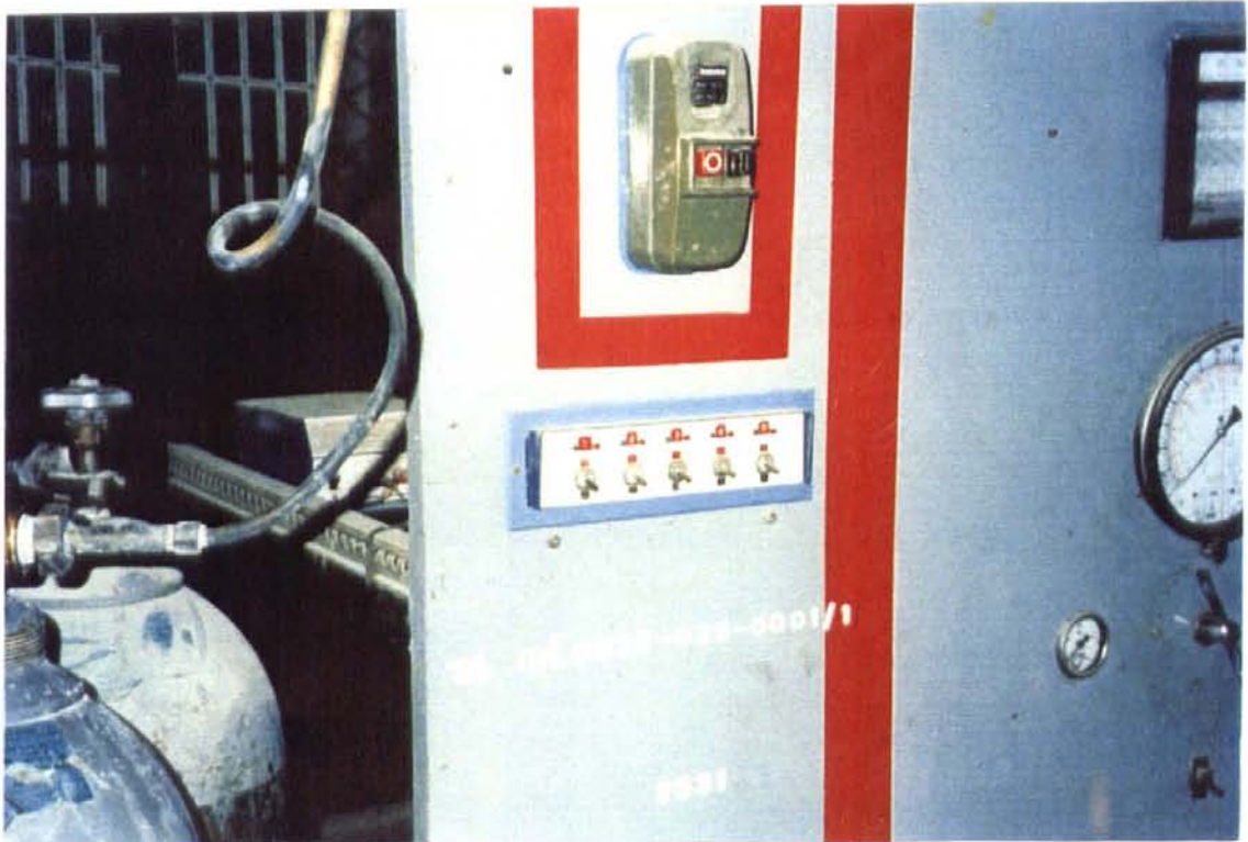
รูปที่ 6 แสดงการติดตั้งเครื่องควบคุมระบบอัตโนมัติเข้ากับเครื่องทดสอบท่อพีวีซี
