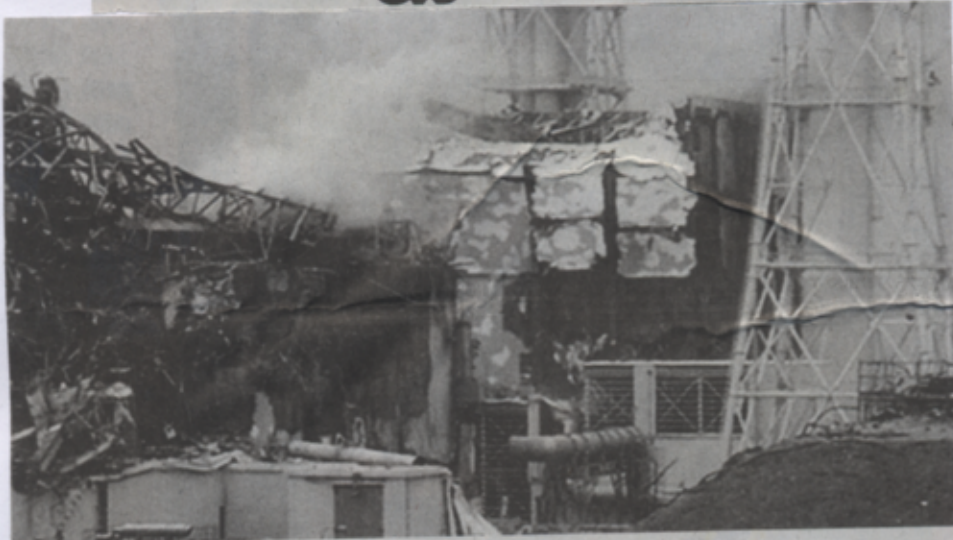
สถานีกำเนิดไฟฟ้าพลังนิวเคลียร์ฟูกูชิมะ ไดอิจิ หลังประสบภัยแผ่นดินไหวและสึนามิ ทำให้เตาปฏิกรณ์นิวเคลียร์รุ่น GE Mark I ชำรุดเสียหาย ปลดออกมันตันภาพรังสีออกมา
