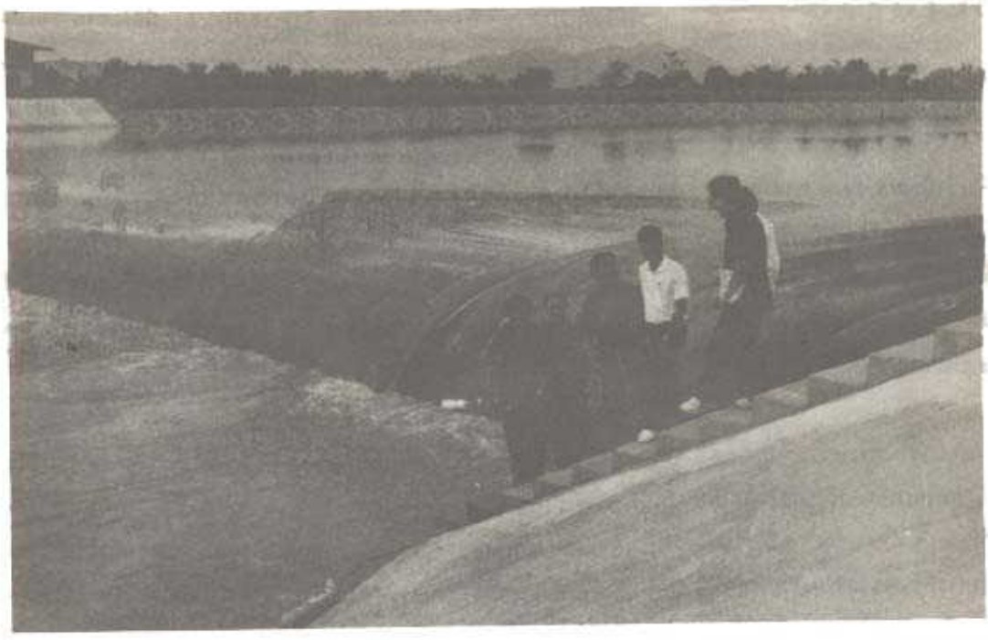
ความยาวฝายทางที่ฐาน 72 เมตร ความยาวสันฝาย 86 เมตร ความสูงเต็มที่ 3.5 เมตร ปริมาณน้ำที่กักเก็บ 4.2 ล้านล.บ.เมตร
