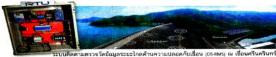
ระบบติดตามตรวจวัดข้อมูลระยะไกลด้านความปลอดภัยเขื่อน (DS-RMS) ณ เขื่อนศรีนครินทร์
