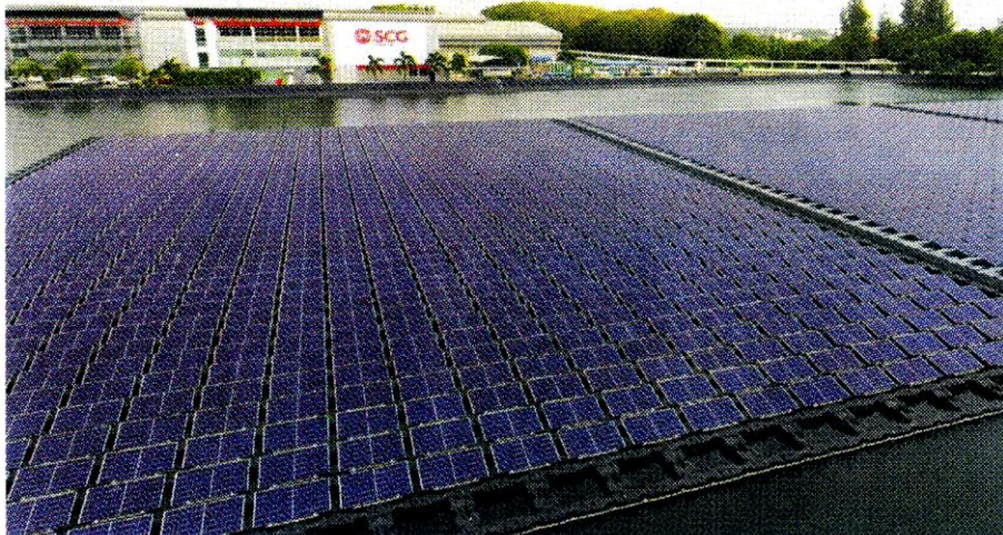
เอสซีจี ระยอง ติดตั้งโซลาร์ฟาร์มลอยน้ำ 1 เมกะวัตต์แห่งแรกของไทย
