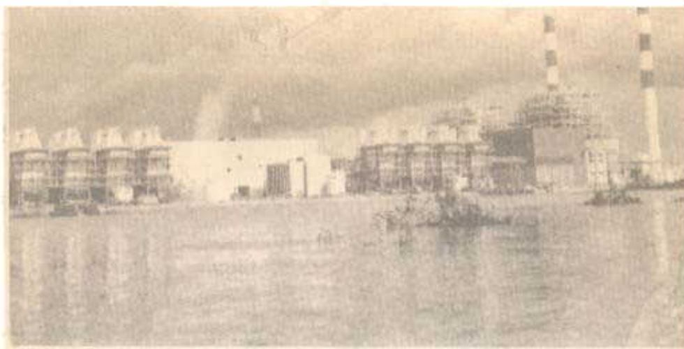
โรงไฟฟ้าบางปะกง สภานิติบัญญัติโรงไฟฟ้าสาขากองทัพเรือเมืองสิง
