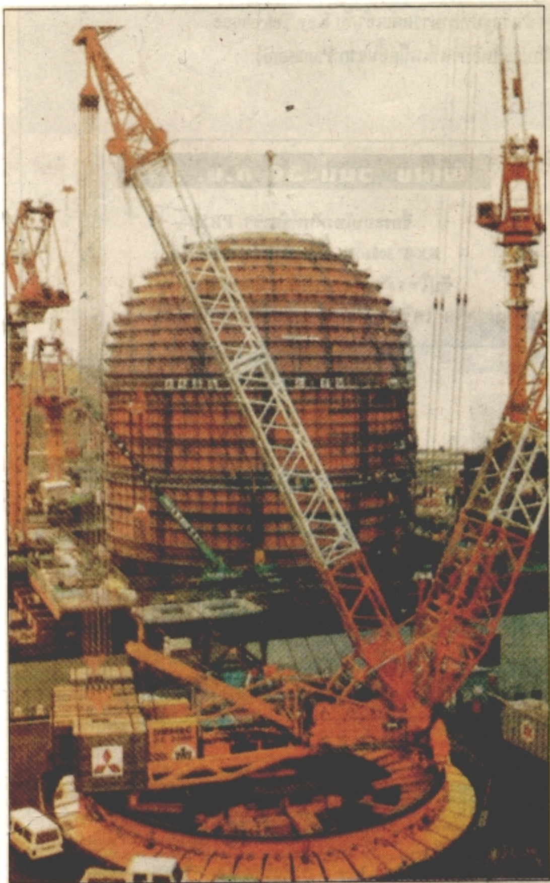
โรงไฟฟ้านิวเคลียร์แห่งหนึ่งระหว่างการก่อสร้าง
