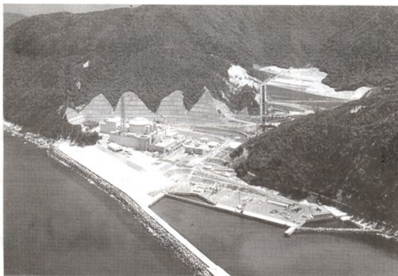
ลักษณะของโรงไฟฟ้านิวเคลียร์ที่ต่างประเทศในแถบยุโรปสร้างขึ้นมาเพื่อเป็นพลังงานทดแทนอีกรูปแบบหนึ่ง ซึ่งในอนาคตประเทศไทยอาจจะมีการสร้างโรงไฟฟ้าประเภทนี้ใช้เช่นกัน
