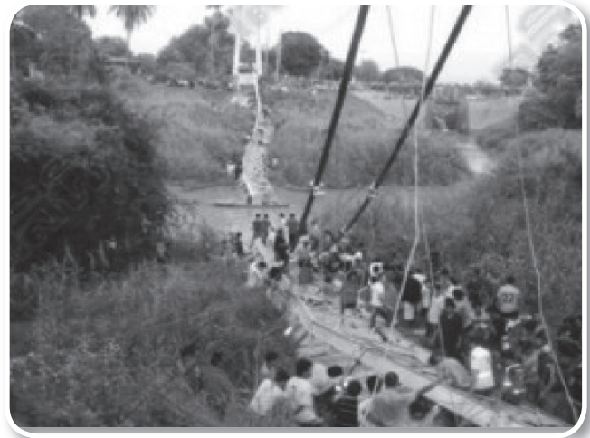
รูปที่ 2 สะพานแขวนข้ามแม่น้ำป่าสักจังหวัดพระนครศรีอยุธยาพังถล่ม
