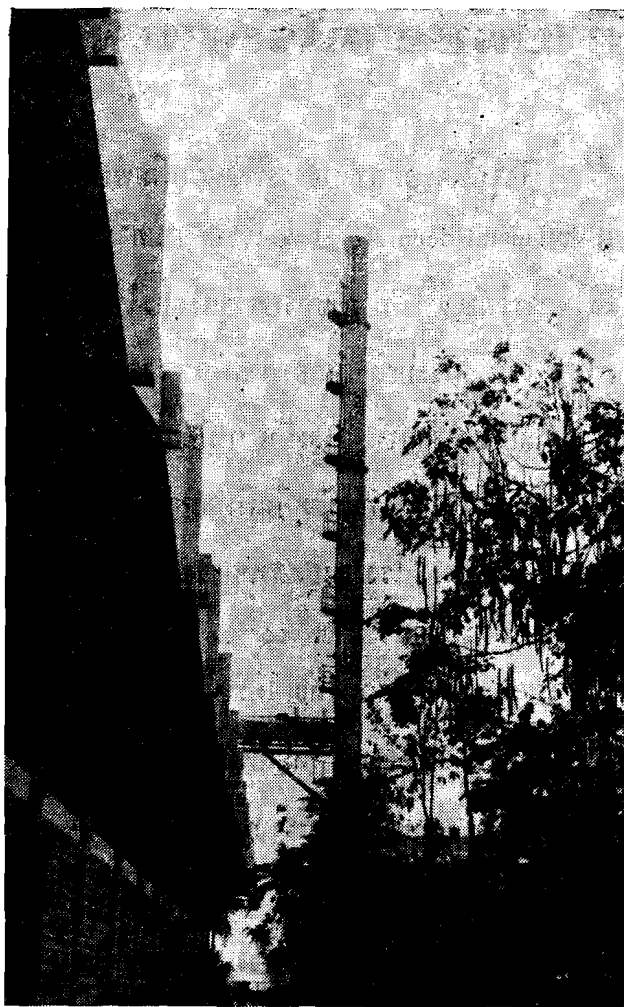
ปล่องกำจัดควันก๊าซโดยวิธี wet absorption process สูงประมาณ ๓๐ เมตร
