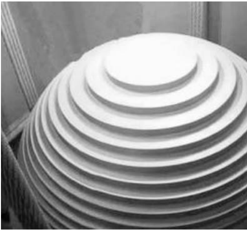
ภาพที่ 4 tuned mass damping (TMD)
