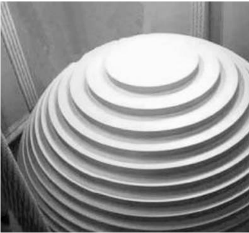
ภาพที่ 4 tuned mass damping (TMD)
