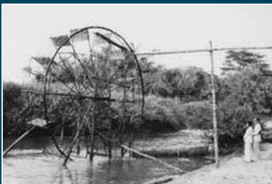
ภาพที่ 1 หลกหรือระหัดวิดน้ำ
