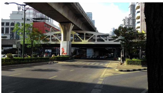
สะพานคอนกรีตเสริมเหล็ก
