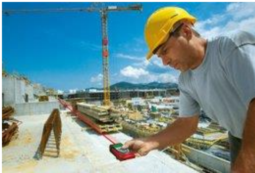
รูปที่ 1 เครื่องวัดระยะชนิดเลเซอร์ (laser distance meter) และการประยุกต์ใช้งาน
