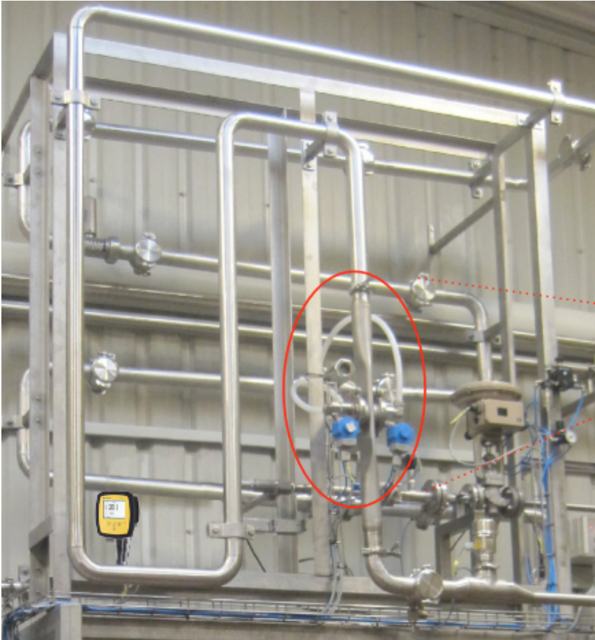
ภาพที่ 3 in-line carbonator โดยมี pinpoint carbonator ติดตั้งอยู่ในวงสีแดง (ที่มา: https://foodandbeverage.pentair.com/en/products/pentair-in-line-pinpoint-carbonator-ppc )
