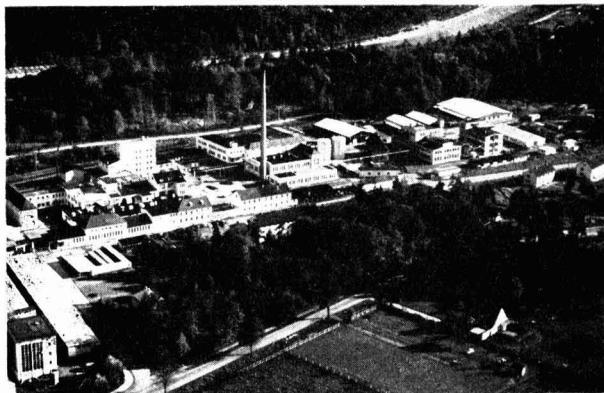
Aerial view of Elektro-Chemische Werke München
